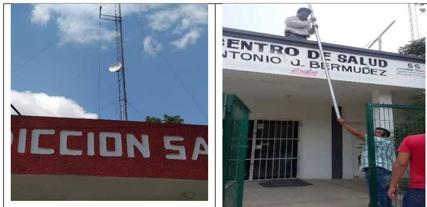
Figura 2.- Docentes instalando antenas de comunicación
