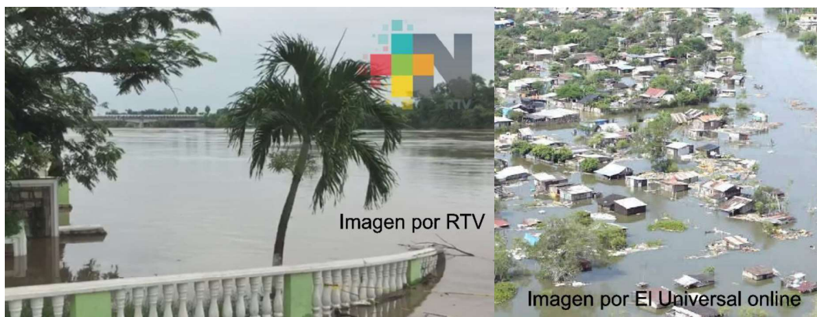
Figura 1. Desbordamiento de ríos y sus afectaciones.
